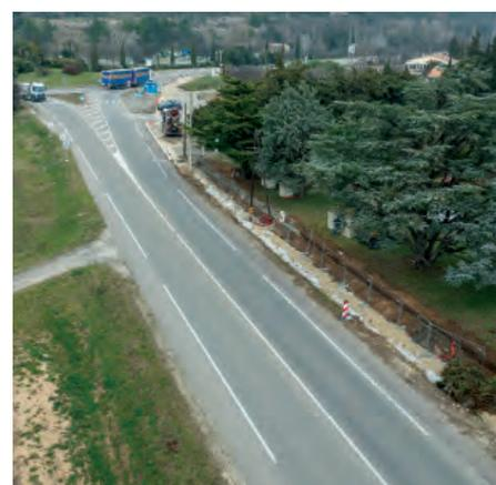
Les travaux d'aménagement de la Route des Alpes avancent. L'enfouissement des réseaux secs est en cours, en attente de la dépose des câbles Enedis et télécom. Les travaux d'évacuation des eaux pluviales sont terminés. Dès fin février, la création d'un cheminement en clavicette débutera pour un mois. Au printemps, les dernières étapes incluront la pose des enrobés et les plantations. Ces travaux visent à moderniser les infrastructures sécurisées et améliorer le cadre de vie des riverains.
